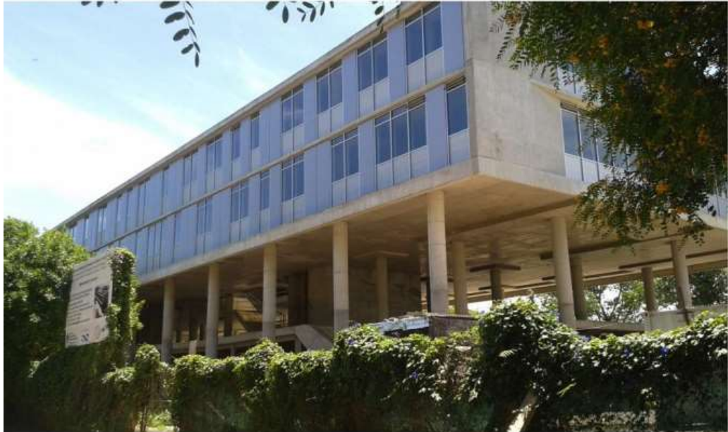
19. Edificio IFIBYNE en obra.
