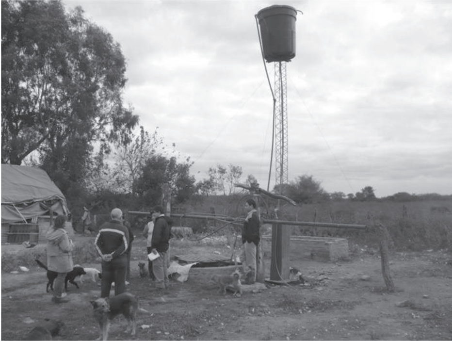
Figura 5-9. Obra de captación en el sitio Los Pereyra: Pozo excavado sin protección equipado con una bomba eléctrica sumergida.
