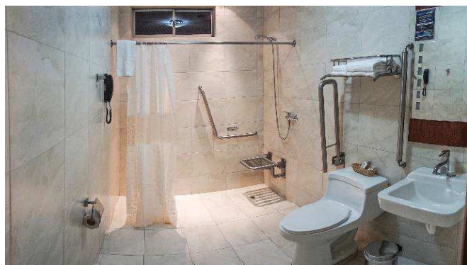
Fotografía 13. Área higiénico sanitaria accesible.
