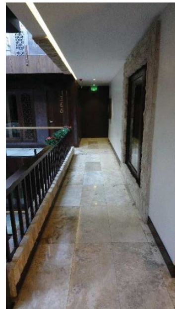
Fotografía 4. Pasamano accesible pasillo. Fuente: Propia.
