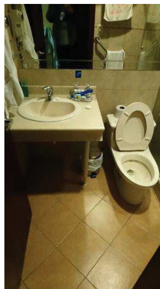
Fotografía 14. Área higiénico-sanitaria parcialmente accesible.
