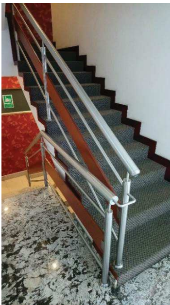
Fotografía 3. Pasamano accesible escalera. Fuente: Propia.
