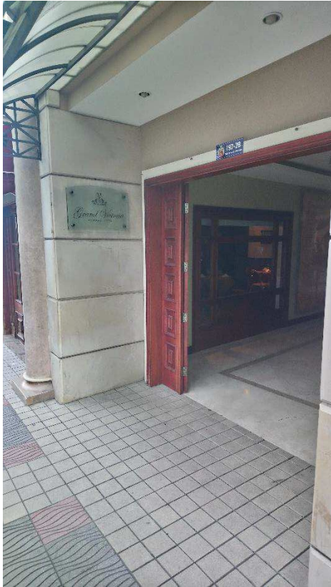
Fotografía 5. Hotel sin necesidad de rampa desde su ingreso. Fuente: Propia.
