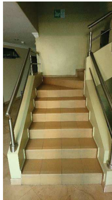
Fotografía 12. Escalera parcialmente accesible. Fuente: Propia.
