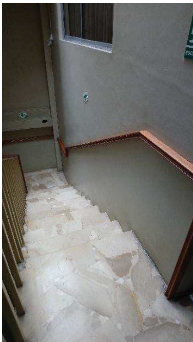
Fotografía 11. Escalera con pasamanos en ambos lados. Fuente: Propia.
