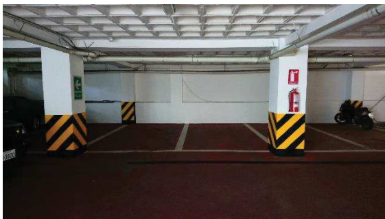
Fotografía 9. Estacionamiento parcialmente accesible.
