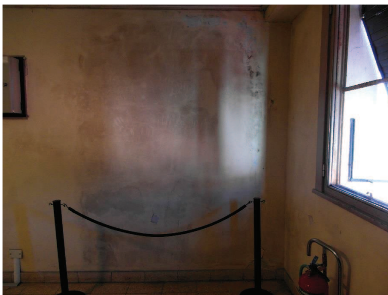
Foto 22. Marca del hueco del ascensor que fue cubierto con pared, ex CCDTyE ESMA. Foto tomada el 6 de agosto de 2016
