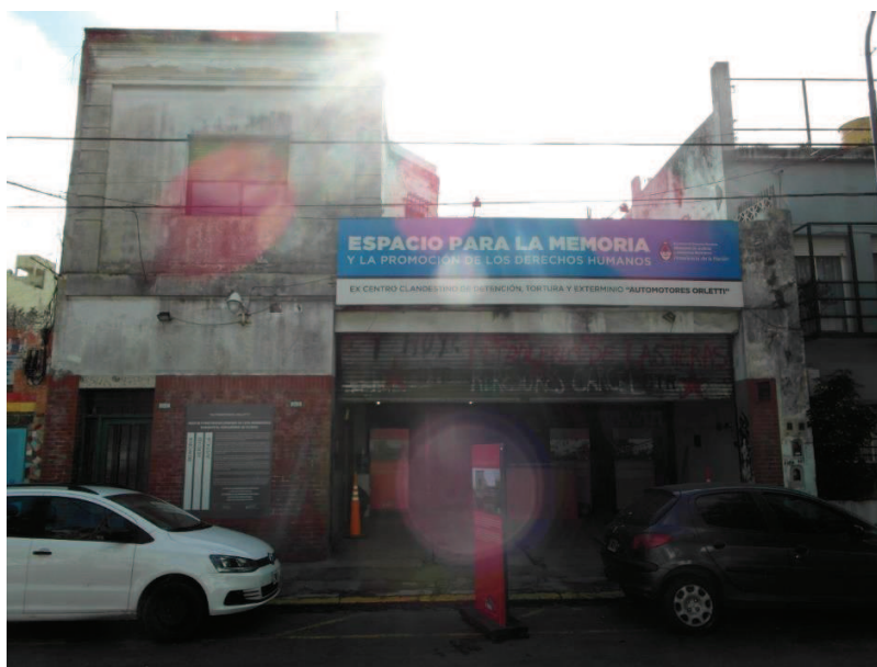
Foto 11. Ex CCDTyE Automotores Orletti, visto desde el exterior. Foto tomada el 3 de agosto de 2016
