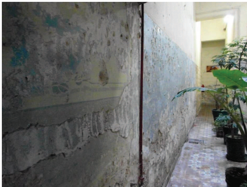
Foto 14. Patio interno en la entrada del ex CCDTyE Virrey Cevallos. Foto tomada el 20 de octubre de 2014
