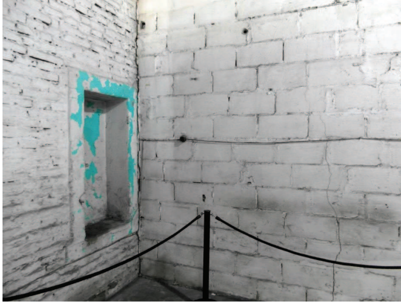
Foto 12. Habitación que fue utilizada como sala de tortura física. La pared de ladrillos grandes y la instalación eléctrica fueron construidas para el acondicionamiento del lugar como centro clandestino. La otra pared pertenece a la construcción original de la casa. Ex CCDTyE Automotores Orletti. Foto tomada el 3 de agosto de 2016
