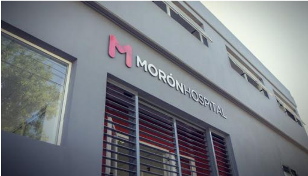
Entrada del Hospital de Morón
