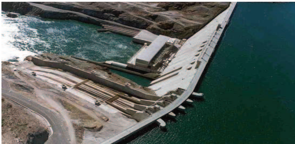
Central Hidroeléctrica con embalse y generación a pie de presa
