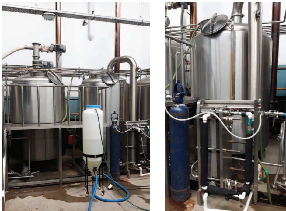
Figura 3.4: Olla de cocción y filtración (izq.) y enfriador (der.) de Cervecería A
