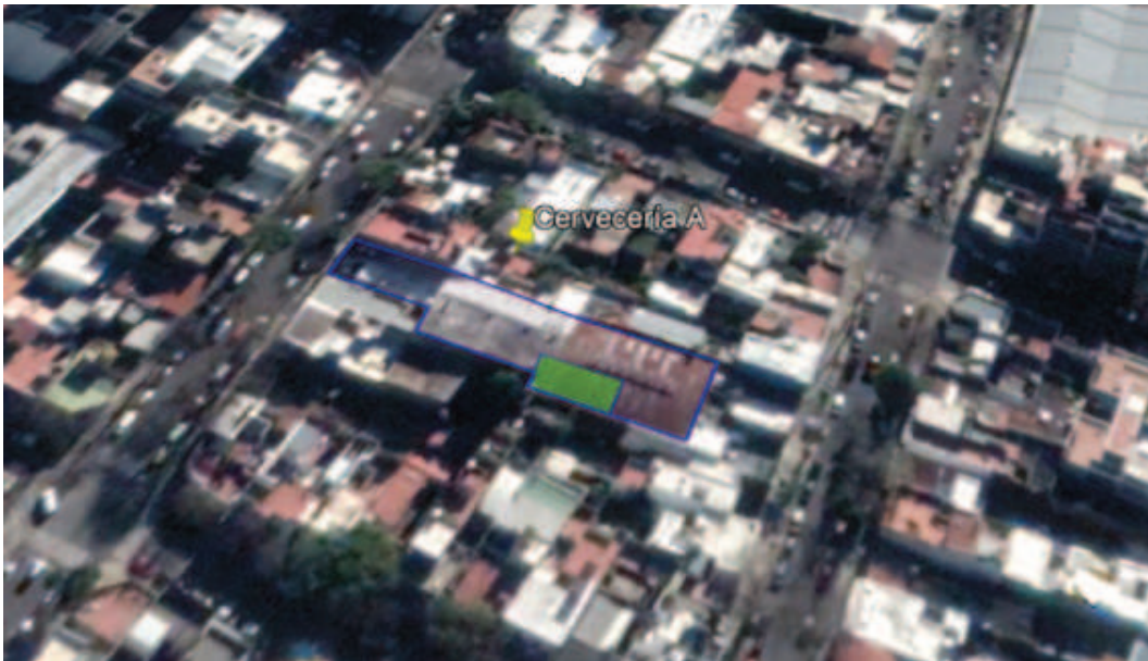
Figura 3.2: Vista superior del predio utilizado como caso de estudio, donde se visualiza delimitados el área total (azul) y el área disponible para el tratamiento (verde).
