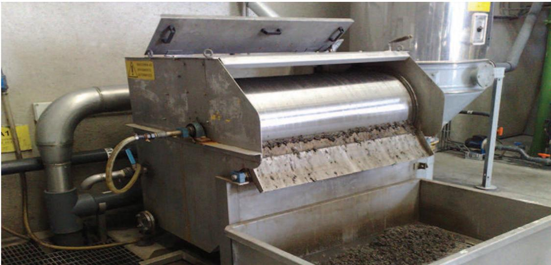
Figura III.I.II Esquema del tamiz. Fuente: Wam Group.
