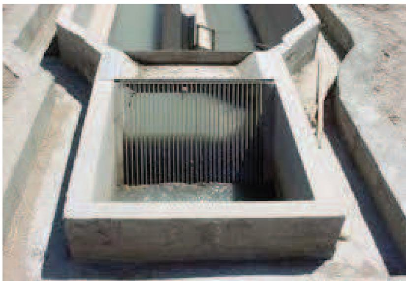
Figura III.I.I Esquema del sistema de rejas. Fuente: Sica.
