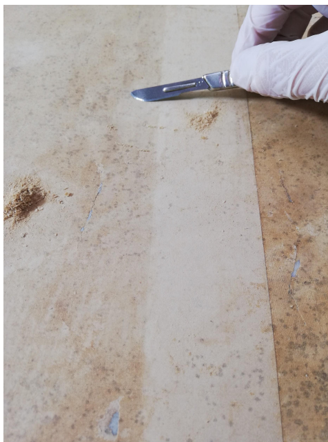
Ilustración 22: Retiro del adhesivo envejecido con ayuda de bisturí (cortesía de la autora).
