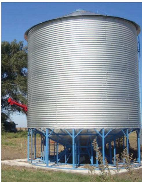
**Figura 5.9.2.1: Silo metálico sugerido para almacenar hidróxido de calcio**
