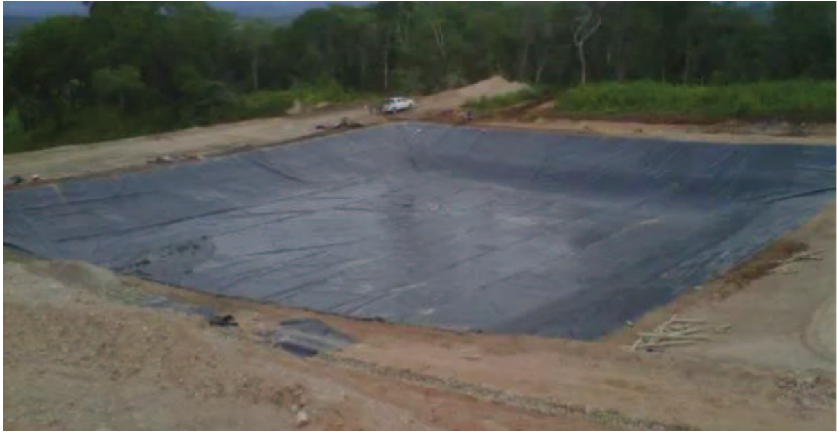
Figura 28. Colocación de geomembrana en un humedal.
