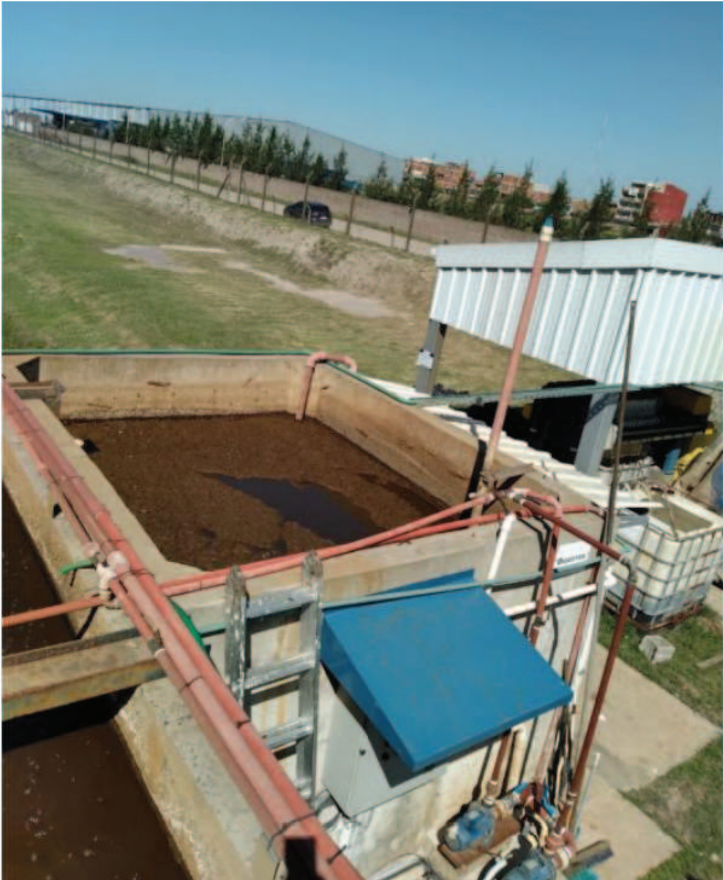
Figura 31. Ejemplo de un digestor aeróbico. Fuente: propia
