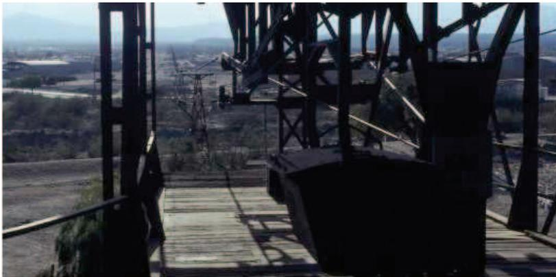
Fotografía. Estación N° 1 en Chilecito. Vista desde la estación N° 1 hacia los Nevados del Famatina (al fondo) y detalle de las vagonetas de carga. Mientras que desde la mina éstas transportaban el mineral pendiente abajo, desde la estación N° 1 se enviaban hacia la mina alimentos, herramientas y correspondencia, entre otros.
