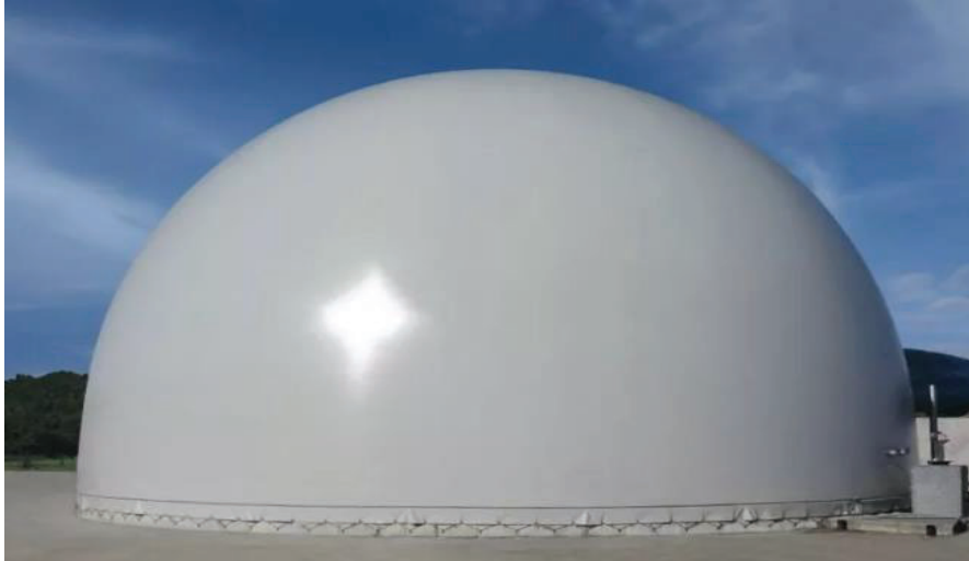
Figura 23: Imagen de Gasómetro de doble membrana con cúpula en forma de 1/2 D. Fuente catalogo del proveedor.
