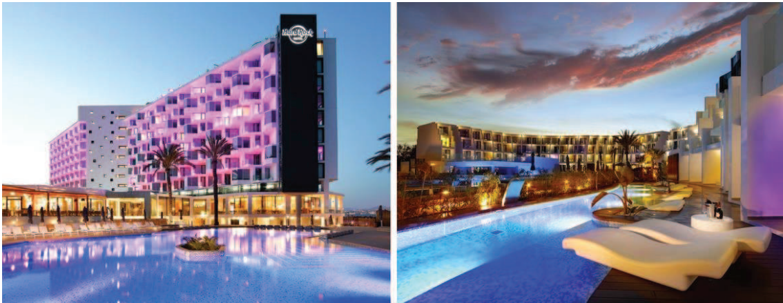
Hard Rock Hotel Ibiza, uno de los más inteligentes del mundo, ubicado en España. Fuente: AP Ingeniería.
