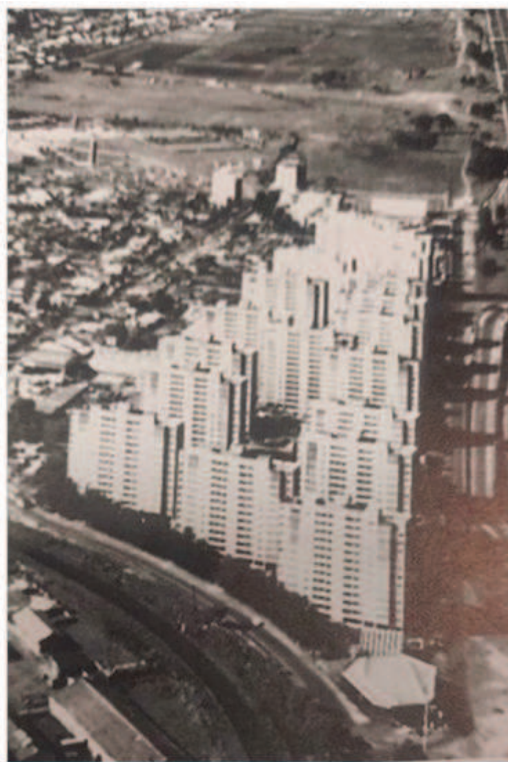
Barrio Autopista, en la localidad de Tapiales, partido de La Matanza (Imagen del libro El hogar Obrero, un siglo de vivienda cooperativa)
