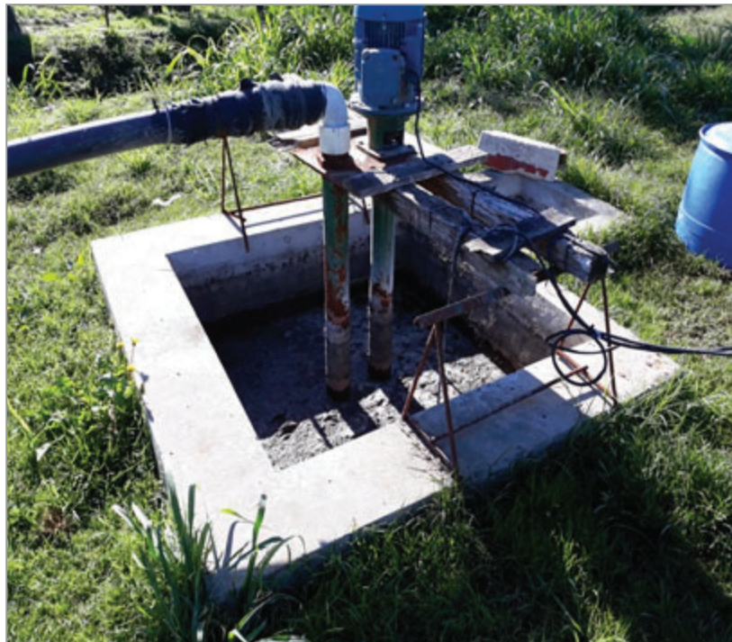
Fig. 1.1: Pileta de sedimentación.
