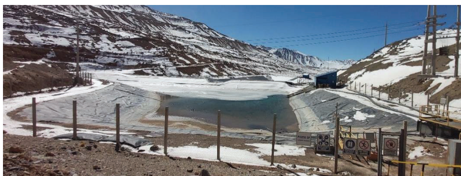
FIGURA 8: IMAGEN DE LA PILETA DE DESCARGA
