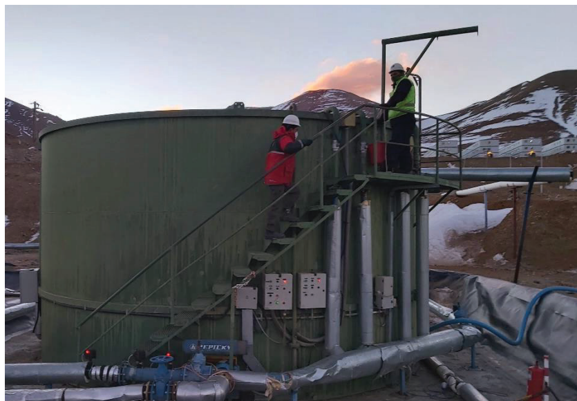
FIGURA 15: IMAGEN DEL MUESTREO EN EL ECUALIZADOR DE LA PLANTA DE A.
