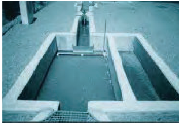
Figura N° 35. Cámara desengrasadora. Fuente. (CENTA, 2008)
