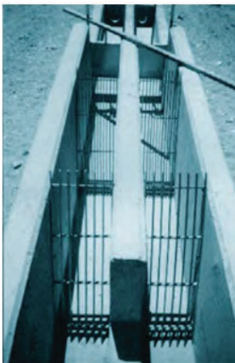
Figura N° 33. Desbaste de gruesos seguido de desbaste de finos, de limpieza manual.
