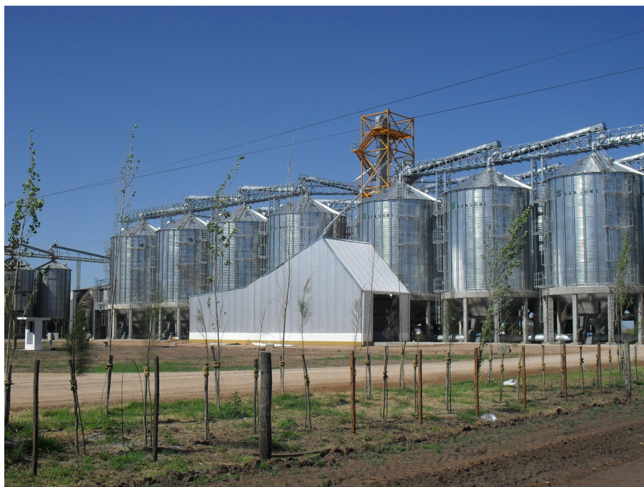
Foto 21: Modernización. Pueblo Sanandrés, enero 2012.
