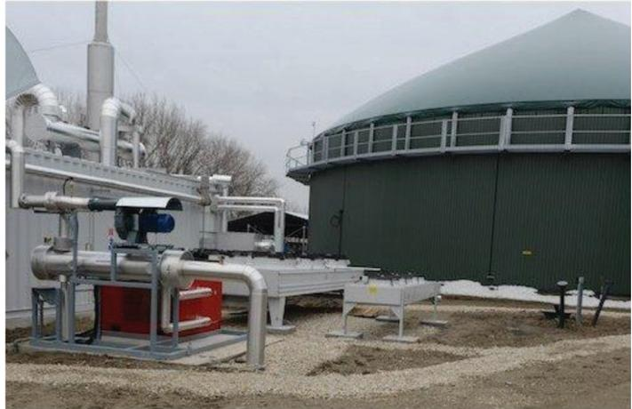
**Figura 8.20.** Imagen esquemática del equipo deshumidificador de biogás MDU 150. Obtenido de [www.vosmik-engineering.com](http://www.vosmik-engineering.com)
