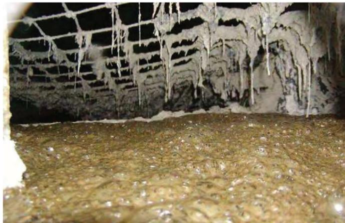
**Figura 8.16.** Soporte para el crecimiento de la biomasa del sistema de desulfuración. Obtenido de Beil et al. (2010)
