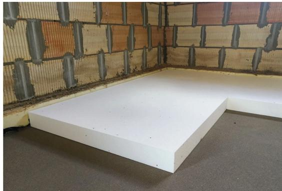
**Figura 8.7.** Colocación de placas de poliestireno expandido en el piso. Obtenido de [www.buyinsulationonline.co.uk](http://www.buyinsulationonline.co.uk)
