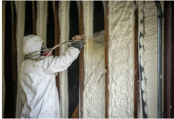
**Figura 8.6.** Colocación de espuma de poliuretano. Obtenido de [www.oneinsulation.co.uk](http://www.oneinsulation.co.uk)
