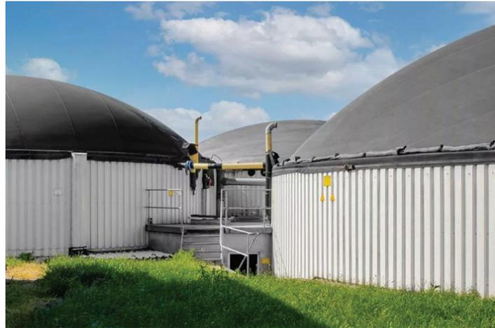
**Figura 8.8.** Gasómetro de membrana simple instalado en un biodigestor. Obtenido de [www.zorg-biogas.com](http://www.zorg-biogas.com)
