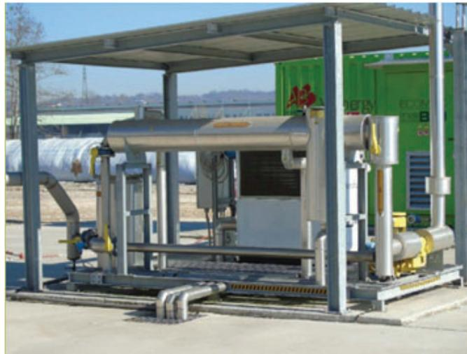
**Figura 4.6.** Sistema *chiller* para el secado del biogás. Obtenido de FAO (2019)
