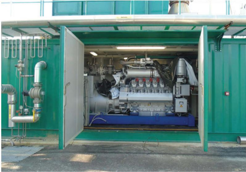
**Figura 4.8.** Motor cogenerador de energía eléctrica y térmica. Obtenido de FAO (2019)
