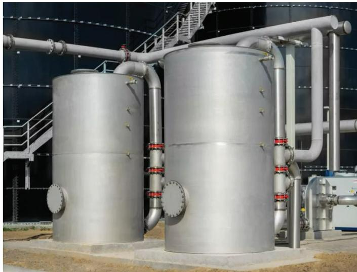
**Figura 8.19.** Imagen ilustrativa del filtro de carbón activado. Obtenido de [www.zorg-biogas.com](http://www.zorg-biogas.com)
