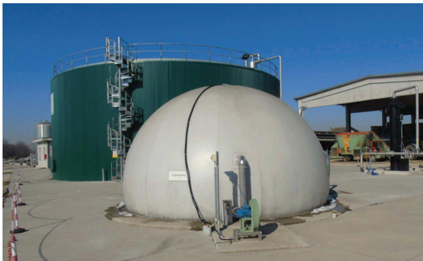
**Figura 4.4.** Biodigestor de mezcla completa. Obtenido de FAO (2019)
