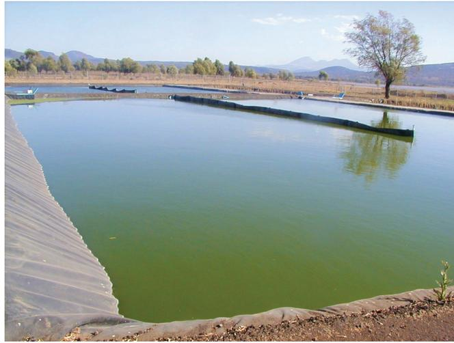
**Figura 8.24.** Laguna impermeabilizada instalada en una zona semiárida. Obtenido de [www.sswm.info](http://www.sswm.info)
