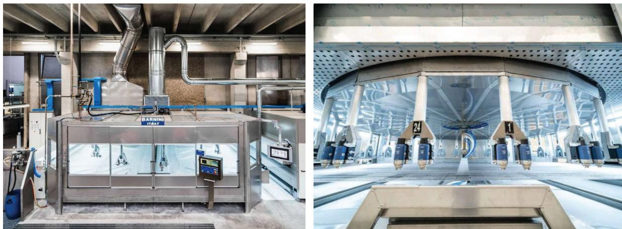
**Figura 50:** Izq.: Conducto de captación de COVs, propuesto para la cabina de pintado. Der.: Orificios dentro de la cabina de pintado, para la distribución del aire de succión. Ref.: [12].
