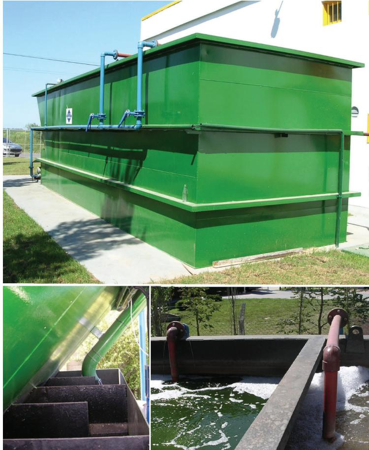
*Figura XXVII: Planta de tratamiento compacta que incluye un reactor de lodos activos, un sedimentador secundario rectangular y un tanque de cloración en un mismo módulo. Fuente: GESTAM ARGENTINA*
