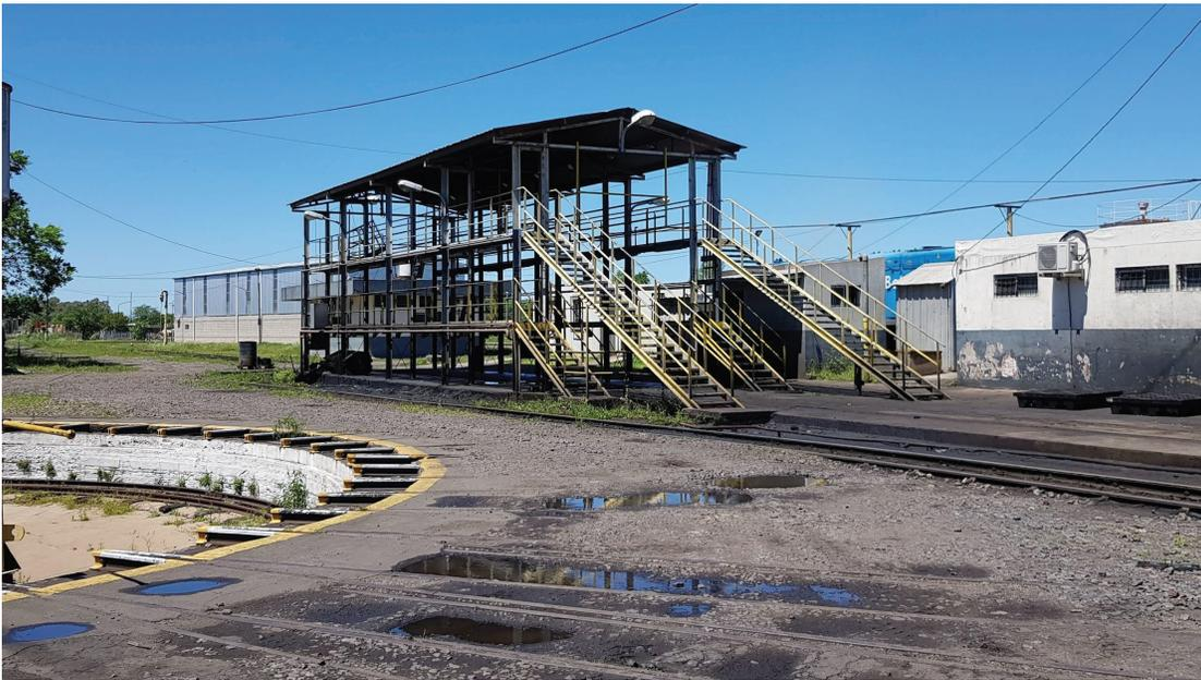
*Fig.XI: Plataforma destinada al lavado de formaciones correspondiente a la empresa Trenes Argentinos Operaciones, ubicada en el predio de Remedios de Escalada, partido de Lanús. Fuente: Elaboración propia.*
