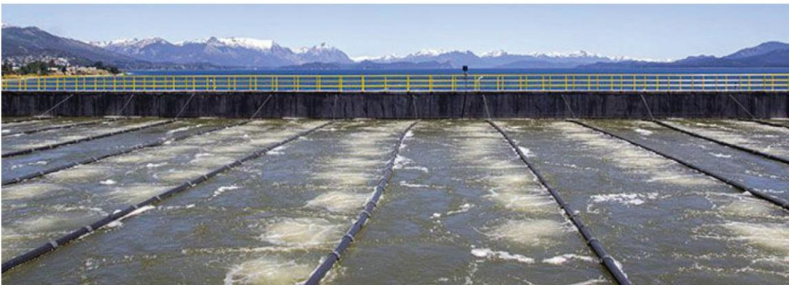
*Fig. XXV: Laguna aireada mecánicamente por medio de un sistema de cadenas flotantes de aireación. (Fuente: Aeration Argentina)*
