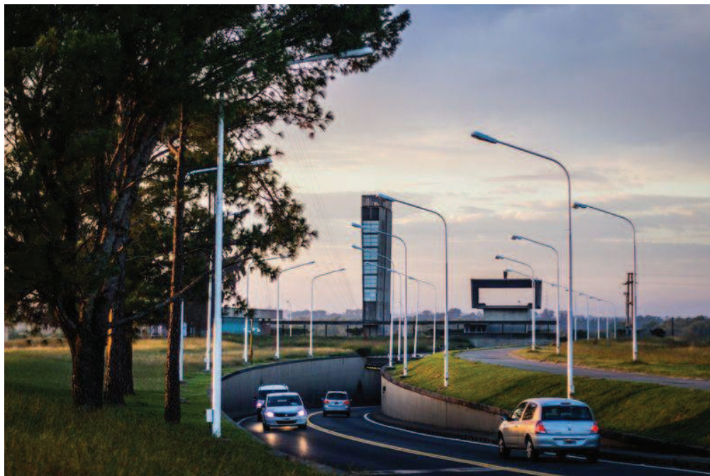
• Figura 2. Entrada túnel subfluvial Paraná- Santa Fe
