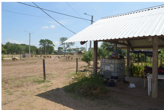
Foto 8. Cobertizo para planta eléctrica. Al fondo la avenida con los chivos. Tamaquito 2
