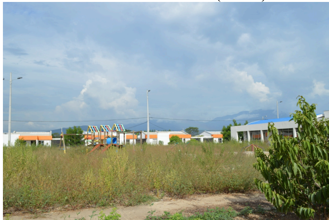
Foto 11. Reasentamiento Las Casitas - Barrancas
