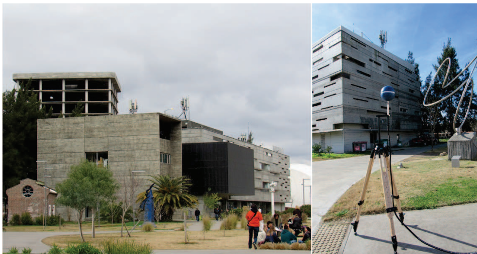
Figura 6.4: Fotos del sitio de medición mostrando los sistemas irradiantes
