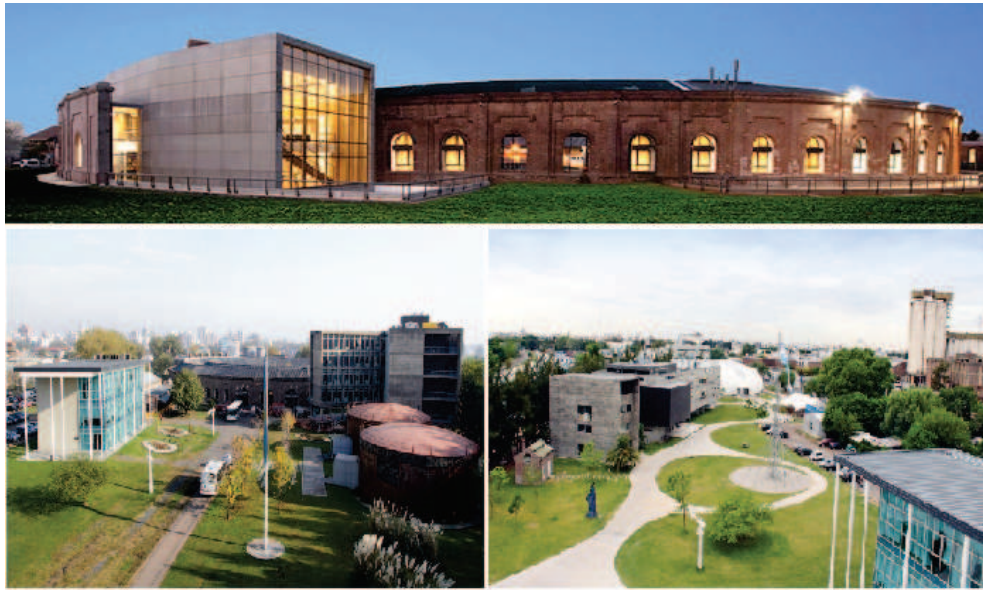
Figura 6.1: Fotos de la Sede de la UNSAM
