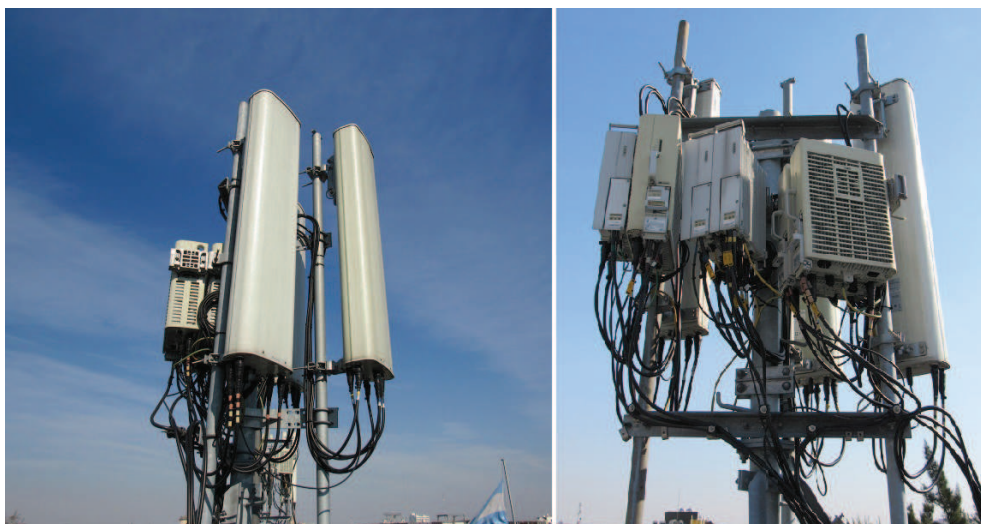
Figura 6.19: Fotos de la Instalación del emplazamiento sector A
