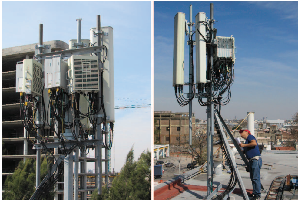
Figura 6.20: Fotos de la Instalación del emplazamiento sector B
