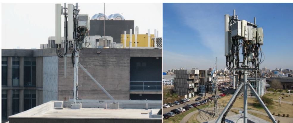
Figura 6.21: Fotos de la Instalación del emplazamiento sector C
