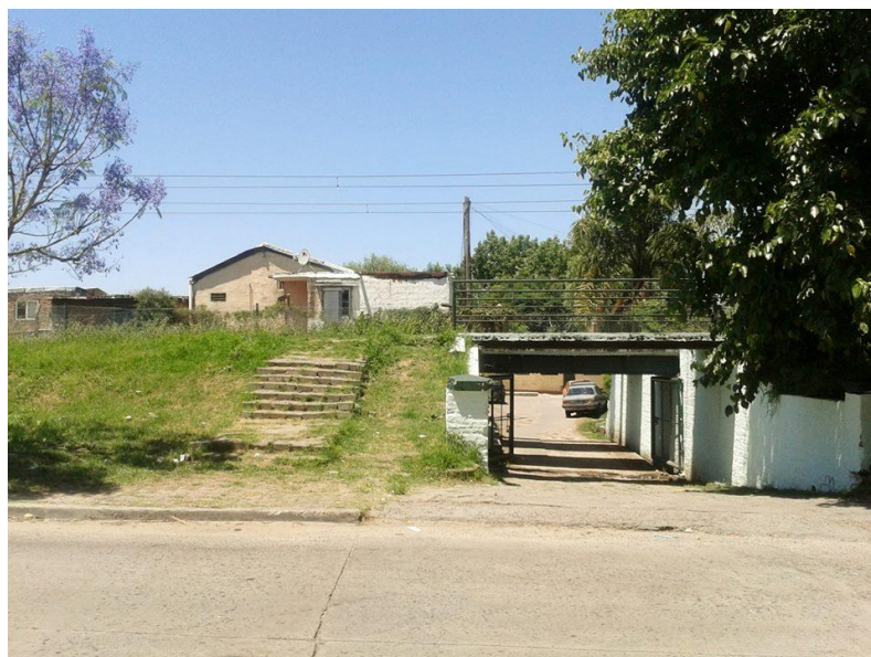
Uno de los viaductos de entrada al barrio La Ribera (noviembre de 2014).
