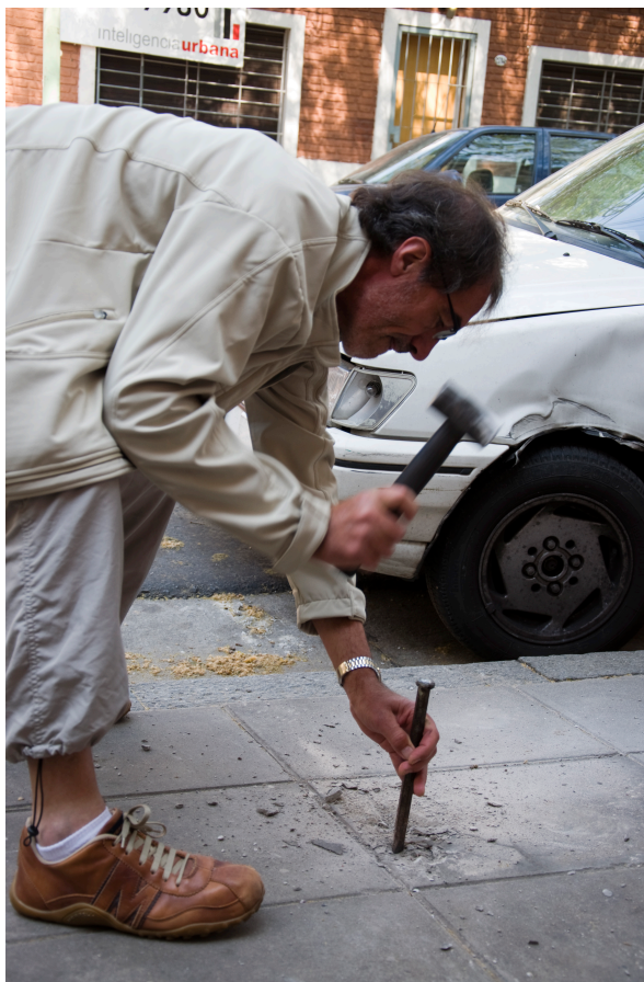
(El autor de este trabajo preparando la cavidad para la baldosa. Foto nro. 12)
