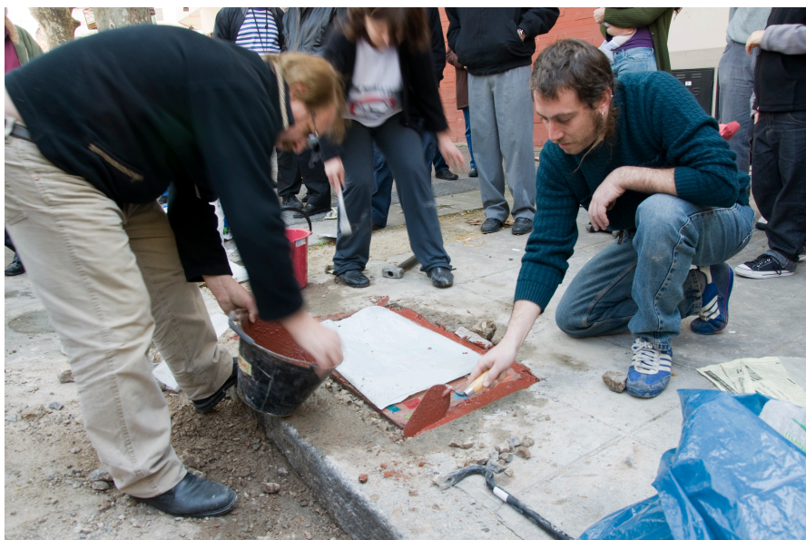
(Foto de los vecinos terminando de cementar la baldosa. Foto del autor nro. 16)
