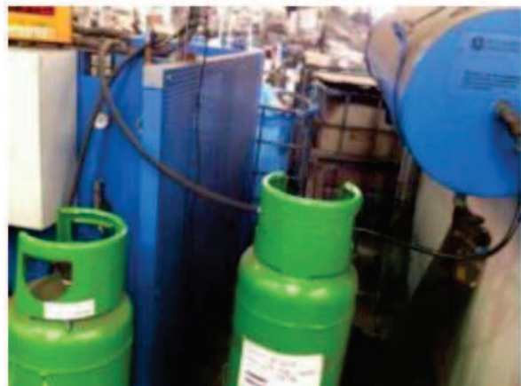
Figura 4-13. Detalle de la máquina de extracción de gases y aceites. Detalle del almacenamiento del aceite y de los gases en bombonas separadas e identificadas. Recuperado de MITECO, 2016.
