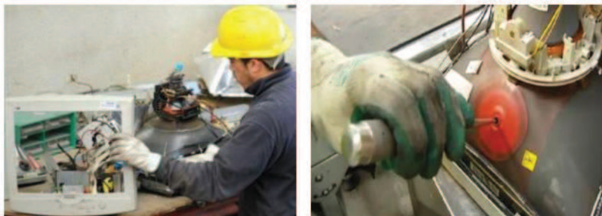
Figura 4-18. Desmontaje de la carcasa exterior y eliminación del vacío del monitor de Tubo de Rayos Catódicos. Recuperado de MITECO, 2016.
