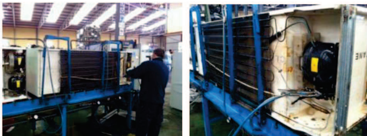
Figura 4-10. Detalle de la retirada de cables y la extracción de gases refrigerantes y aceites de una heladera. Recuperado de MITECO, 2016.
