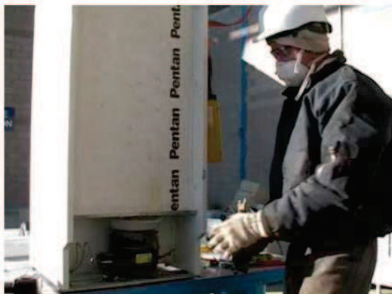
Figura 4-11. Detalle de la extracción del compresor y aceite de una heladera. Recuperado de Fundación Ecolec, 2017.
