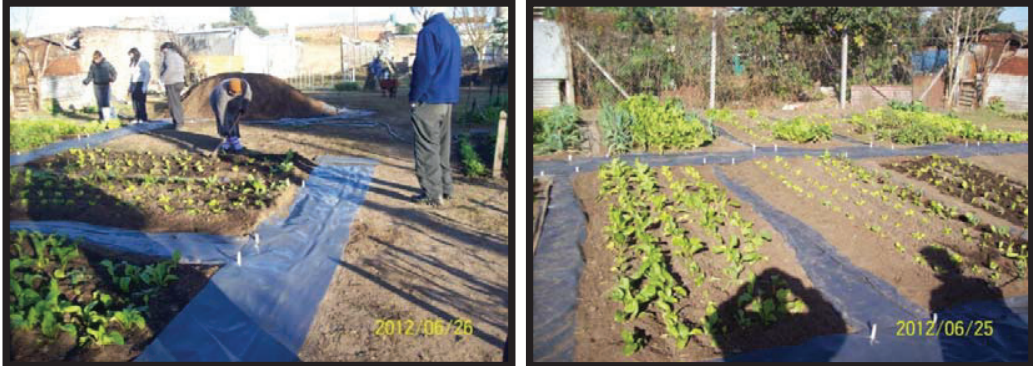
Figura N° 34 Vistas del proceso de aislamiento del suelo contaminado con la geomembrana
