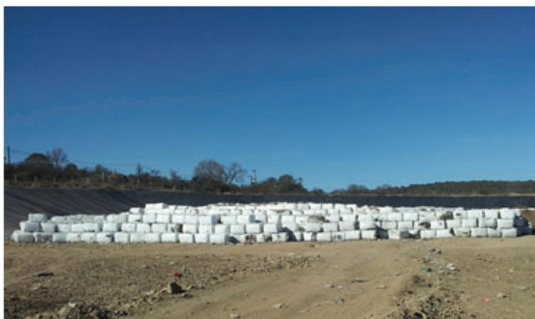
**Foto 40:** Frente de trabajo en relleno de alta densidad por balas.
