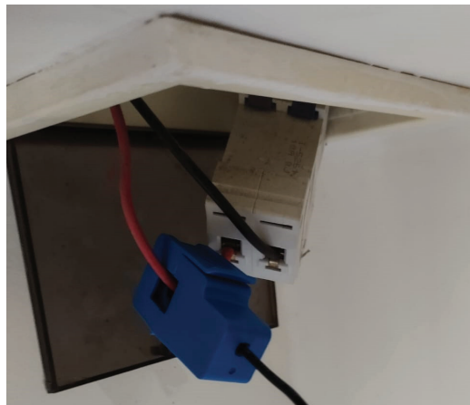
FIGURA 6.3. Instalación de sensor de corriente.
