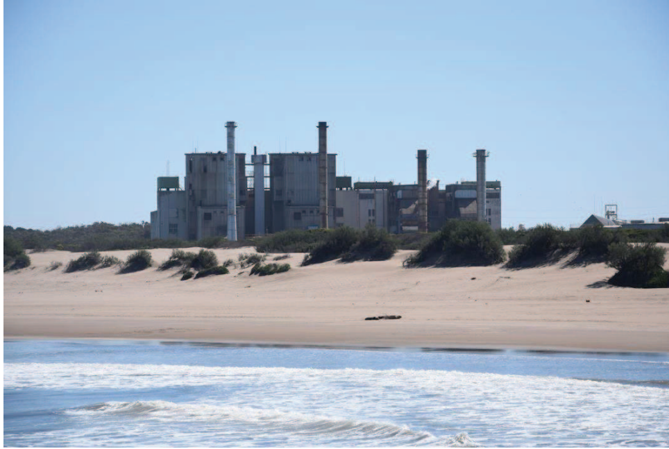
Figura 3: Instalaciones de la Central Termoeléctrica, a pocos metros de la playa turística.
