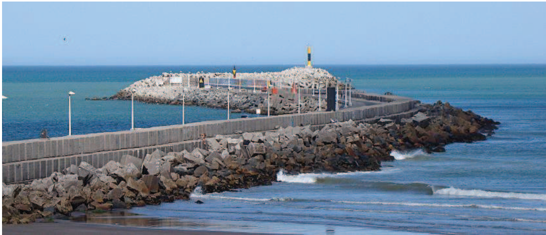
Imagen 9: " Extensión de la Escollera Sur del Puerto de Quequén, principal causa de erosión de las costas de la ciudad".
