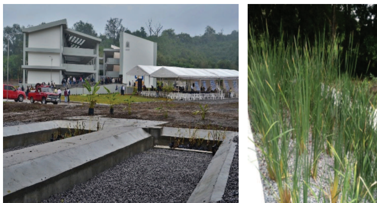
Figura 5. Humedal construido del Campus Huasteca Sur (UASLP). Especie de planta en fotografía: Typha sp. Fuente: Elaboración propia.
