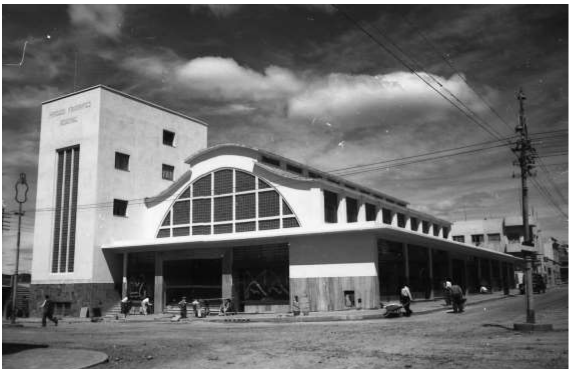
Imagen 28. Construcción del Mercado Frigorífico Regional en la esquina de Rivadavia y Carlos Pellegrini, Comodoro Rivadavia, entre 1951 y 1953 aproximadamente.
