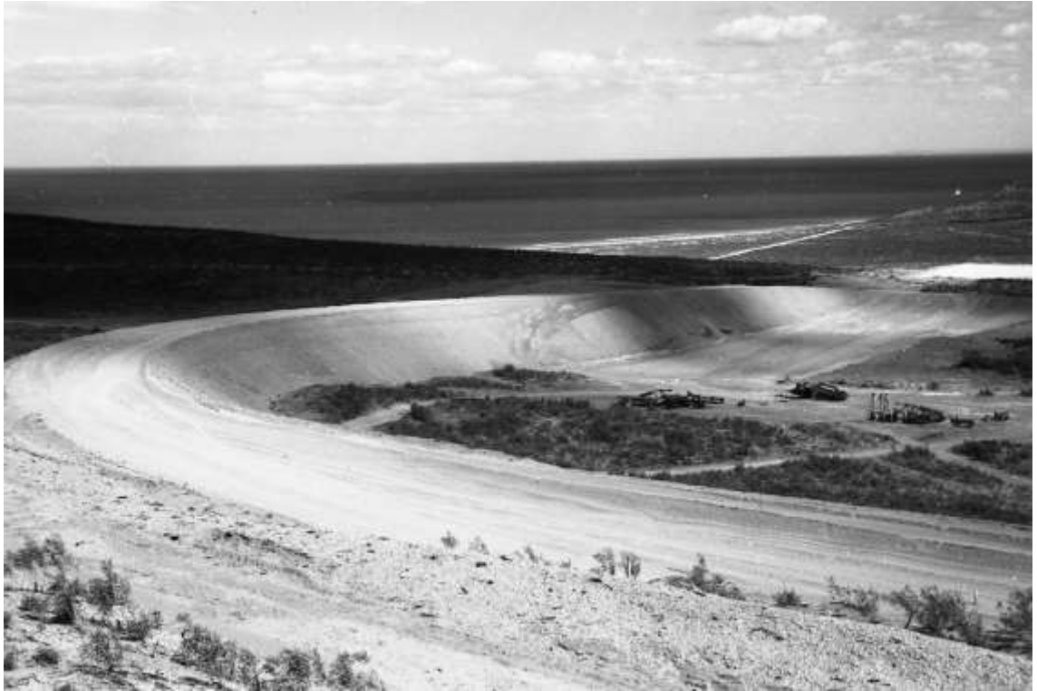
Imagen 21. Acceso sur Ruta Nacional N° 3, Playa Belvedere, noviembre 1952.
