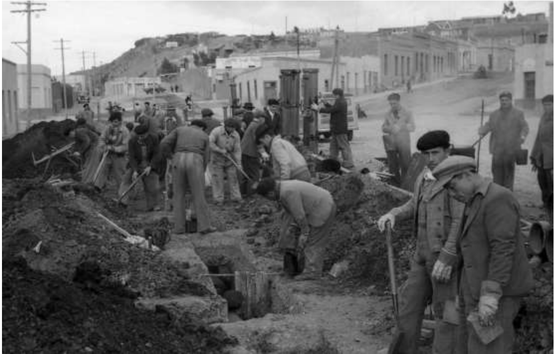
Imagen 33. Construcción de cloacas en Avda. Hipólito Yrigoyen, zona centro de Comodoro Rivadavia, 1950 aproximadamente.
