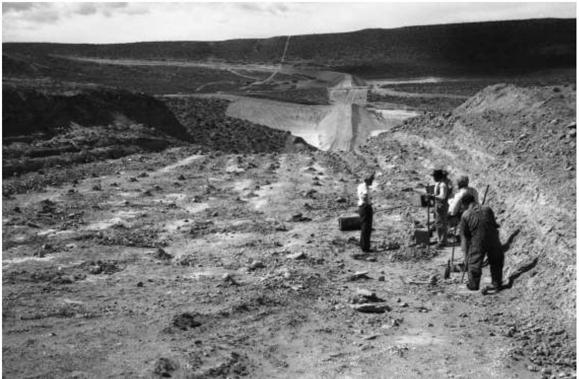
Imagen 22. Acceso sur Ruta Nacional N° 3, Playa Belvedere, noviembre 1952.
