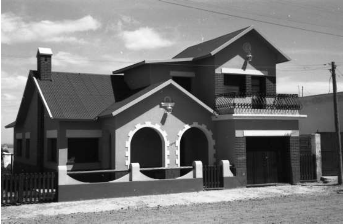
Imagen 35. Vivienda, Comodoro Rivadavia
