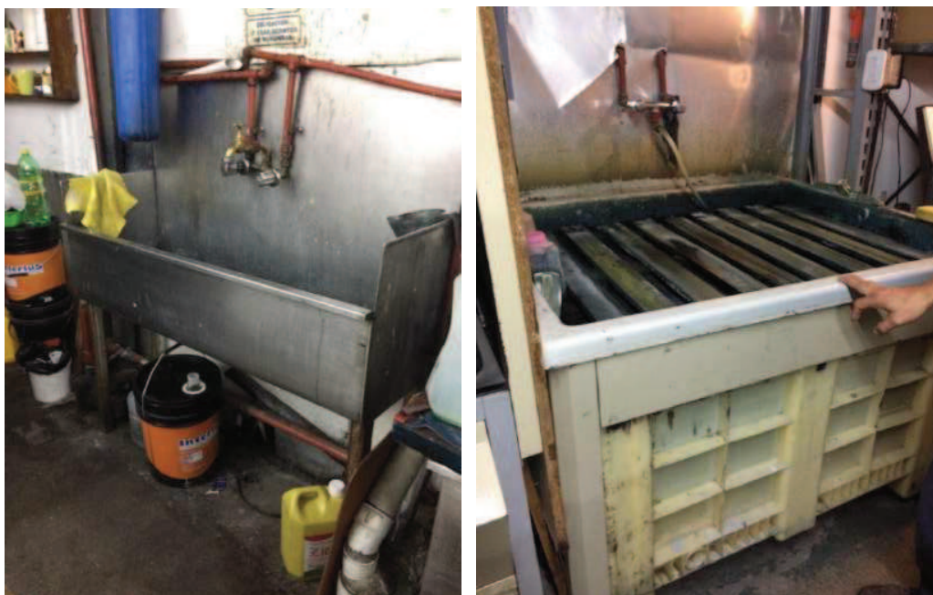
Figura 2.5.8 y 2.5.9: Pileta de lavado para rodillos y planchas de impresión respectivamente. Los efluentes aquí generados son bombeados al tanque de almacenamiento transitorio.
