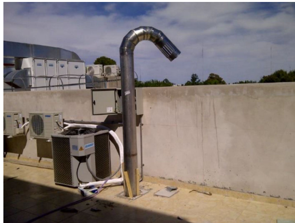
Fig. 29: Tubo de quench con salida a cuatro vientos.
