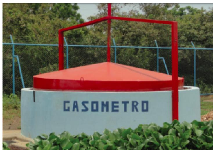
Figura 4.45: Ejemplo de Gasómetro con campana flotante. Fuente: Guía Teórico-Práctica sobre el biogás y los biodigestores, FAO, Argentina, 2019.
