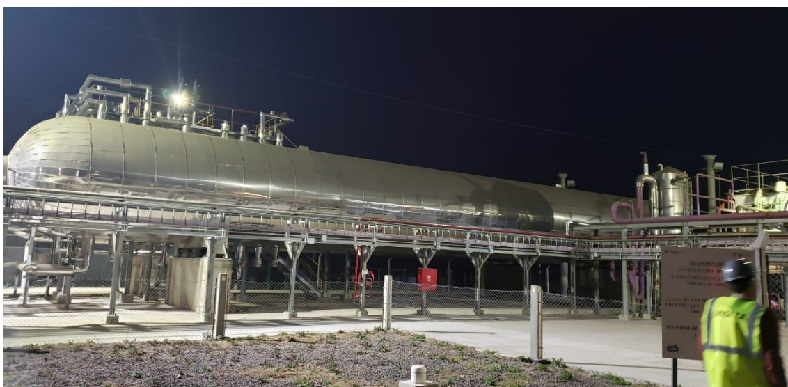
Figura 10. Tanque de almacenamiento de dióxido de carbono licuado, la planta cuenta con dos tanques con una capacidad total de 600 toneladas. Fuente: Foto propia.
