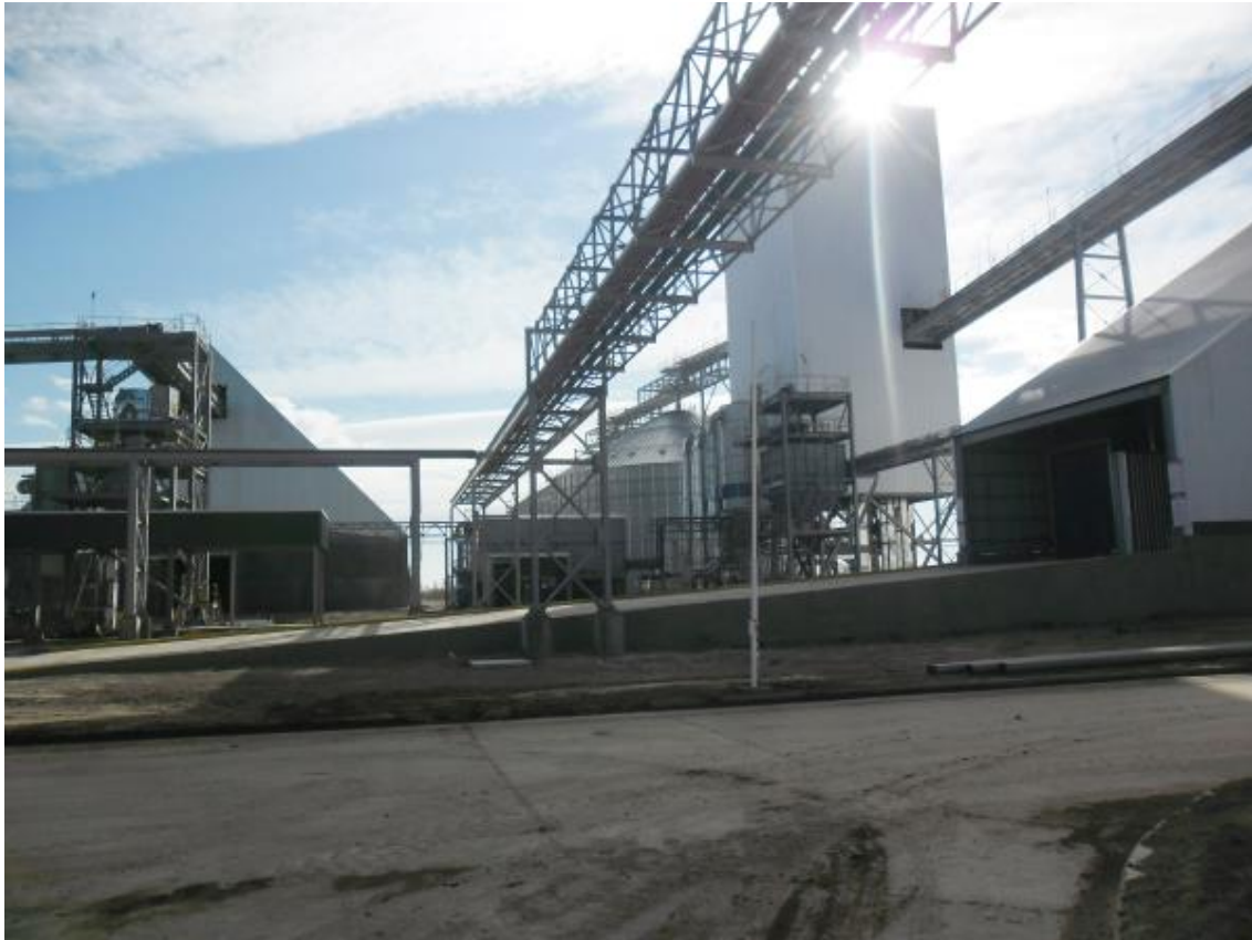
Figura 7. Imagen del silo diario (derecha), celda de almacenamiento de DDGs con una capacidad de 7.000 toneladas (izquierda) y silos de almacenamiento de maíz. Fuente: Google Imágenes.
