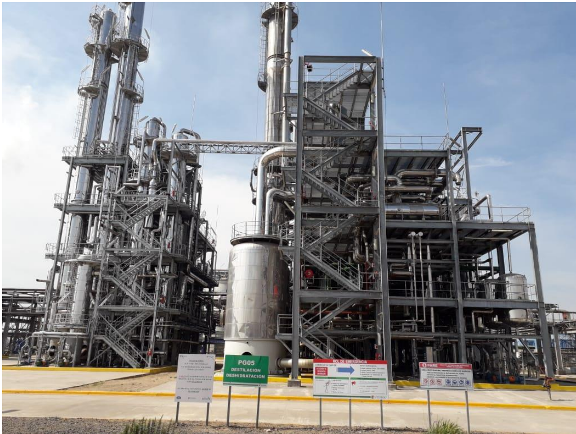
Figura 8. Torres de destilación y equipamiento de anhidración. Fuente: Foto propia.
