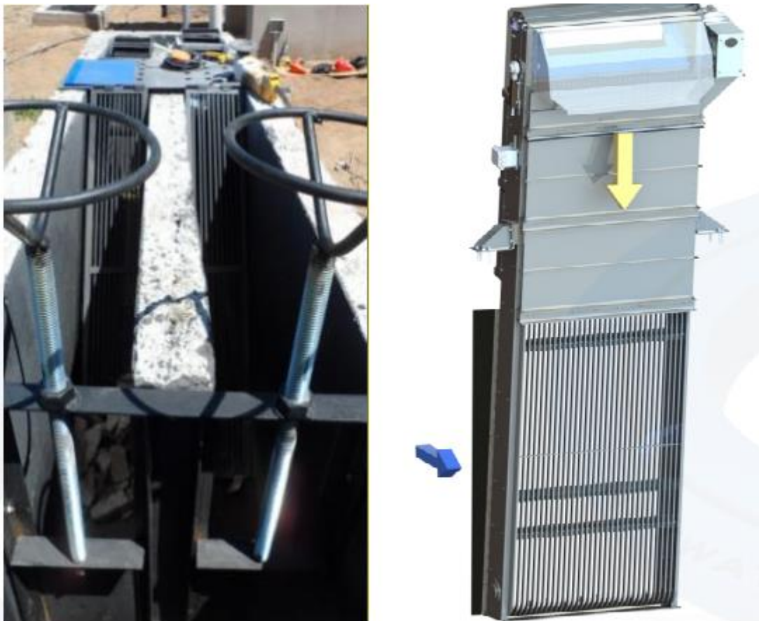
Figura 14. Rejas de limpieza manual (Izquierda) y automática (derecha). Fuente: Cátedra Procesos Industriales y Google imágenes.
