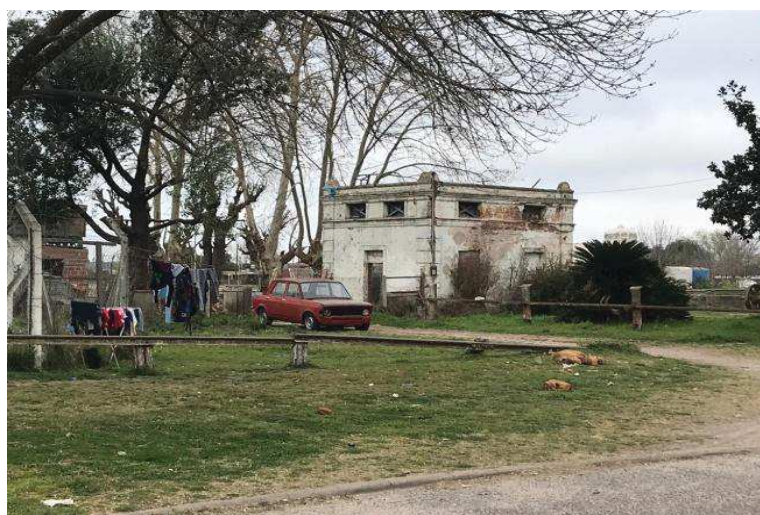
Parte de la Estación de San Antonio de Areco se encuentra tomada por una familia.
