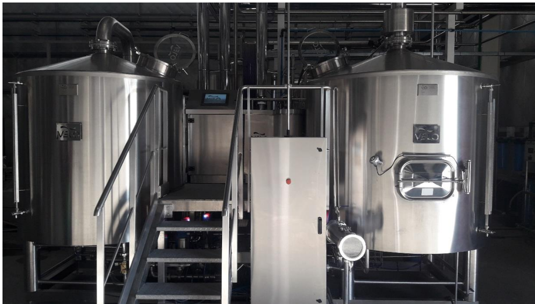
Imagen 3: Bloque de cocción con una capacidad producción de 1.500 litros por lote. A la derecha, se observa la olla de maceración, en el centro la pantalla de control y a la izquierda la olla de hervor.
