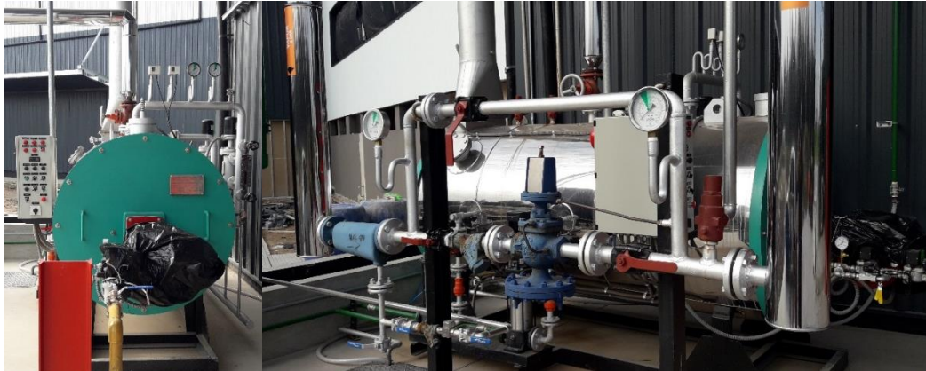
Imagen 5: A la izquierda, vista frontal de la caldera con una capacidad de 600kg/hora. A la derecha, se observa la válvula reductora de presión, y de fondo se aprecia la vista lateral de la caldera.
