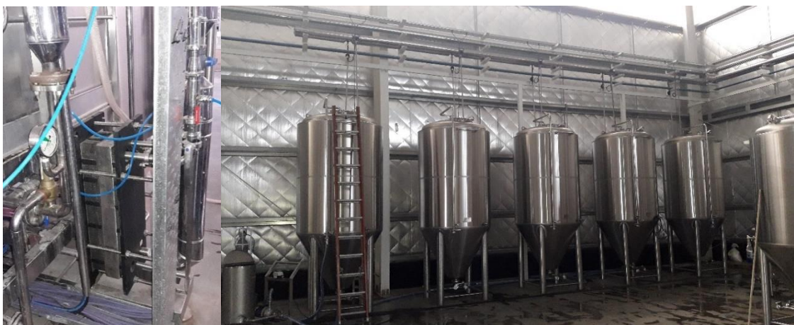
Imagen 7: La imagen de la izquierda muestra el intercambiador de calor utilizado para el enfriamiento del mosto. A la derecha, se observa el bloque frío, donde se ven 6 tanques de fermentación de 3.000 litros de capacidad. Además, hay otros 3 tanques de 1.500 litros que no se observan en la imagen.
