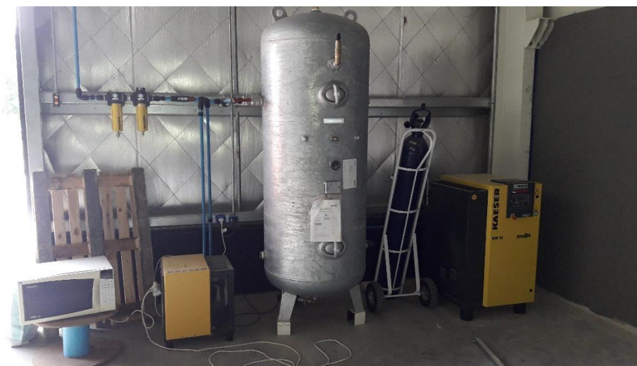
Imagen 10: Instalación de compresión de aire. Se observa el compresor de aire, el tanque de almacenamiento, el secador frigorífico y el juego de filtros para acondicionamiento de aire.
