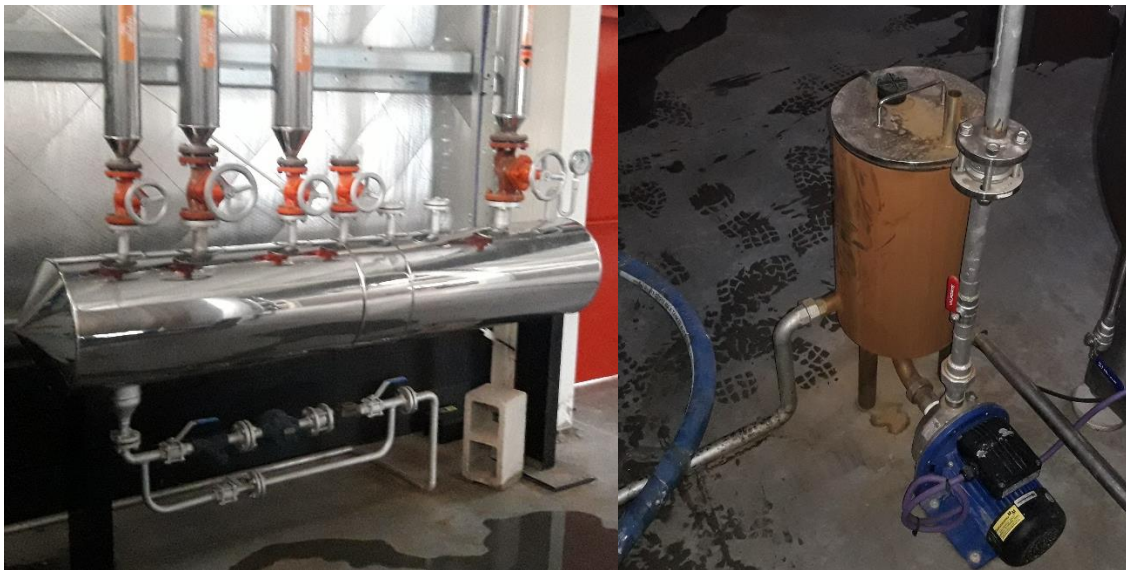
Imagen 6: A la izquierda, se observa el colector de distribución de vapor. A la derecha, se observa el tanque de retorno de condensado utilizado actualmente.
