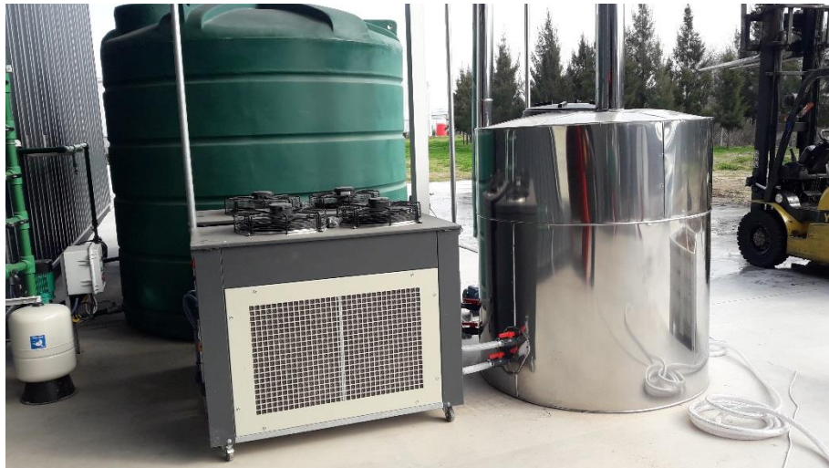
Imagen 8: En esta imagen se muestra parte del sistema de refrigeración de los tanques de fermentación. A la izquierda, se observan 2 bancos de frío (chillers) con una capacidad nominal de 10 TR (toneladas de refrigeración) cada uno. A la derecha, se observa tanque de almacenamiento de agua glicolada de 1.000 litros aislado térmicamente.
