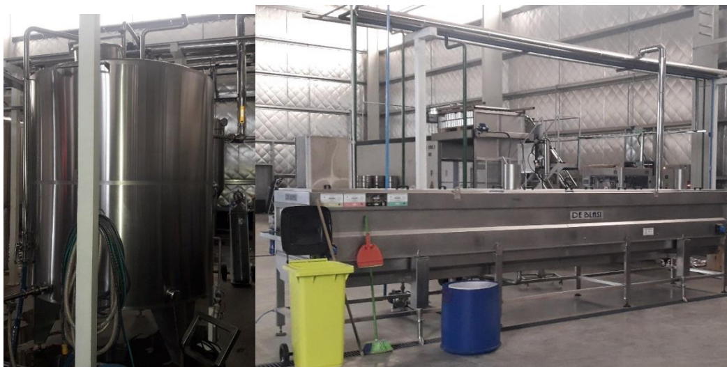
Imagen 4: A la derecha, se observa el pasteurizador tipo túnel con una capacidad nominal de 1.200 latas/hora. A la izquierda, se observa el tanque de agua caliente con una capacidad de 5.000 litros.
