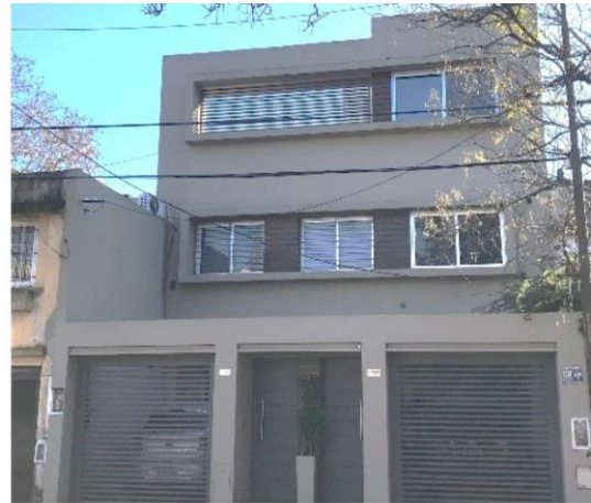
FACHADA TERMINACIÓN CON CEMENTO ALISADO
