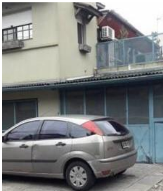
Imagen 8. Fachada de la casa familiar de Rosa y Oscar.
