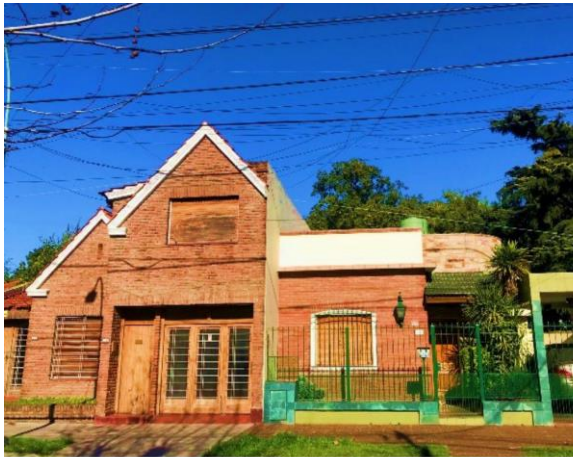
FACHADA LADRILLOS A LA VISTA
