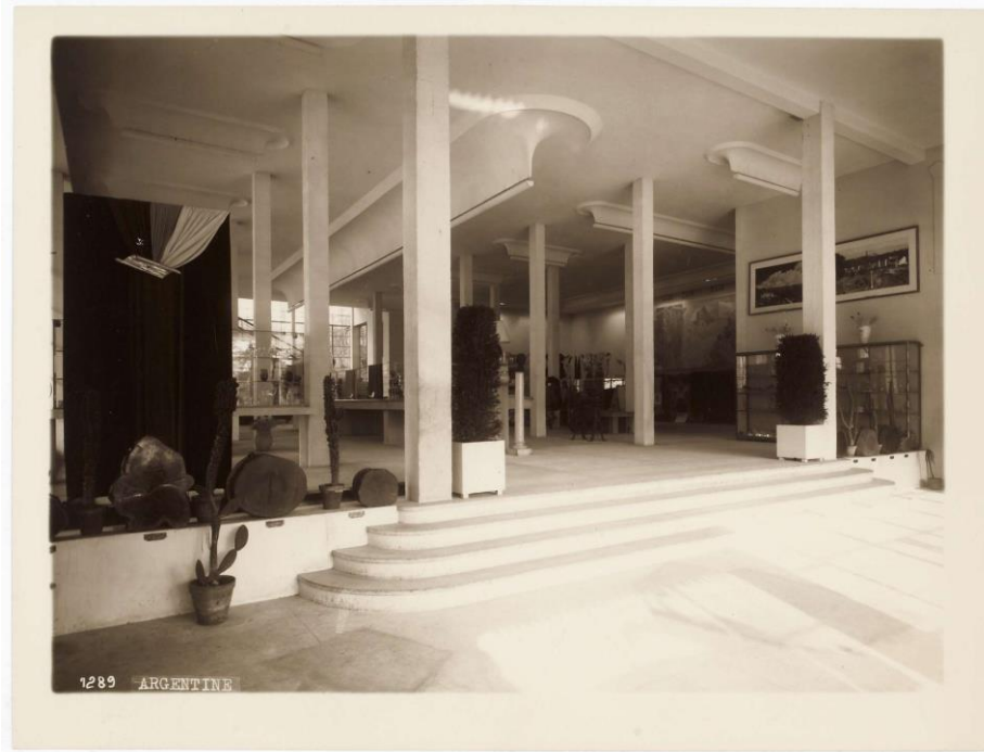
Fig. 7. H. Baranger. Vista del interior del Pabellón de la Argentina en la Exposición Internacional de París de 1937. Archives Nationales, Francia. F/12/12116, (309-1289), 24x18 cm (sin fecha).
