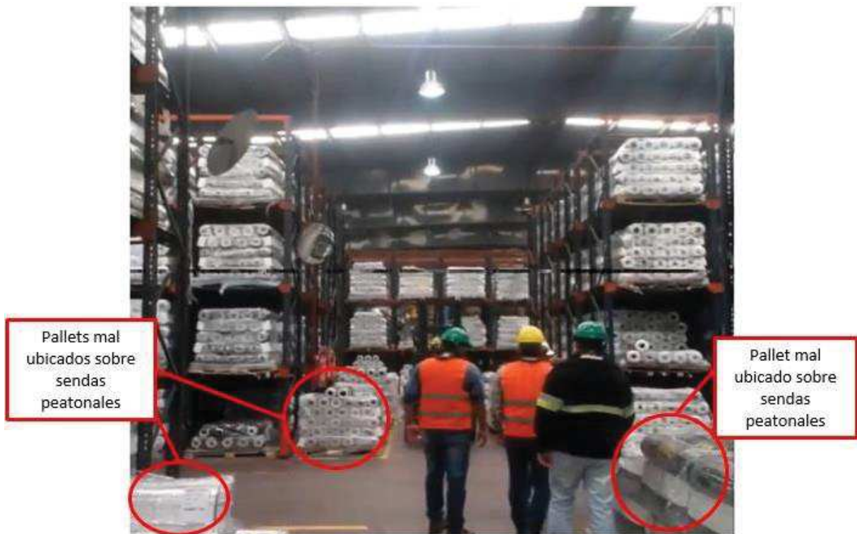
Foto1: recorrida por el interior del Almacén de Productos terminados. Burzaco
