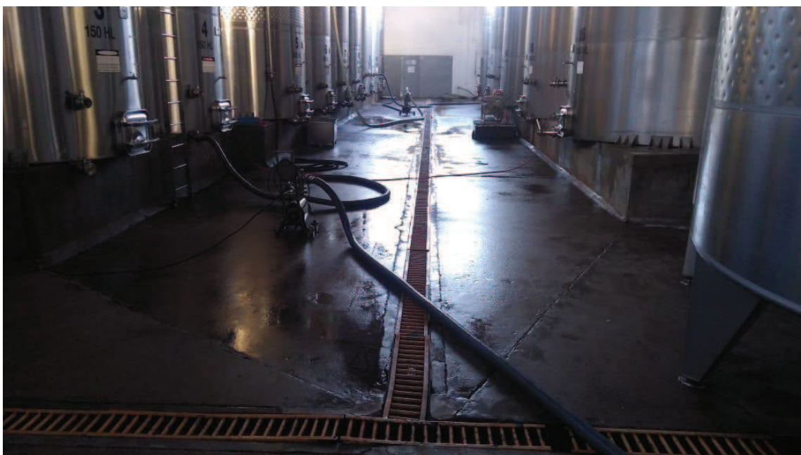
Figura 4.2: Canaleta principal horizontal con rejilla incluida. Fuente: Elaboración propia, 2018.
