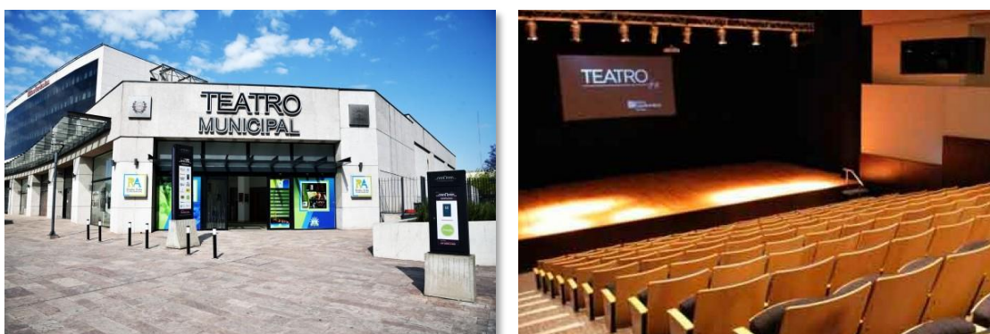
Figura 4: Sala Rosita Ávila, fachada e interior – Fuentes: Sitio oficial de la Municipalidad de San Miguel de Tucumán; El Tucumano , diario digital. 21 de febrero de 2021.
