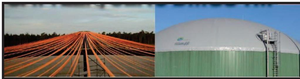
**Figura 4.11: Soporte de la membrana interna (izquierda). Membrana exterior (derecha). Fuente: SATTLER**
