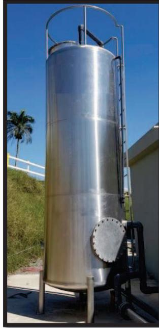
**Imagen 4.3: Filtro de H<sub>2</sub>S de acero inoxidable. Fuente: Romero, Gabriel Moncayo; “Dimensionamiento, diseño y construcción de biodigestores y plantas de Biogás”, 2020.**
