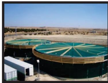
**Imagen 5.3 y 5.4: Digestor en construcción. Fuente: Guía de planificación para proyectos de biogás en Chile.**
