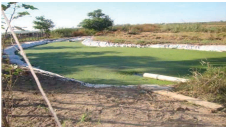
Figura 20: Laguna aerobia (Fuente: Cátedra UNSAM 2019 "Diseño de Tratamiento de Efluentes Biológicos").
