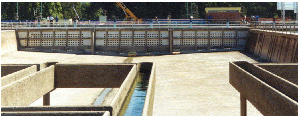
Figura 9: ejemplo de sedimentador primario rectangular.
