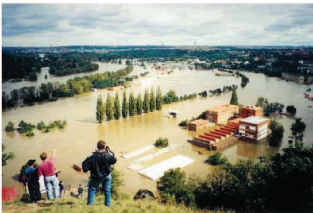
Figura 36: Planta de tratamiento de efluentes de Praga completamente inundada durante una inundación del año 2002 (fuente: Guidance on Water Supply and Sanitation In Extreme Weather Events, WHO, 2011).
