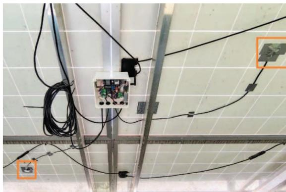
Figura 138 - Adhesión de los sensores PT1000 a la parte posterior de los paneles fotovoltaicos.
