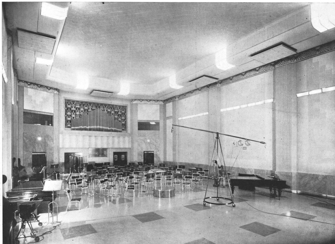
ARQ. A. G. SPANDRI. Edificio para L. R. 1 Radio El Mundo.- El Estudio A
